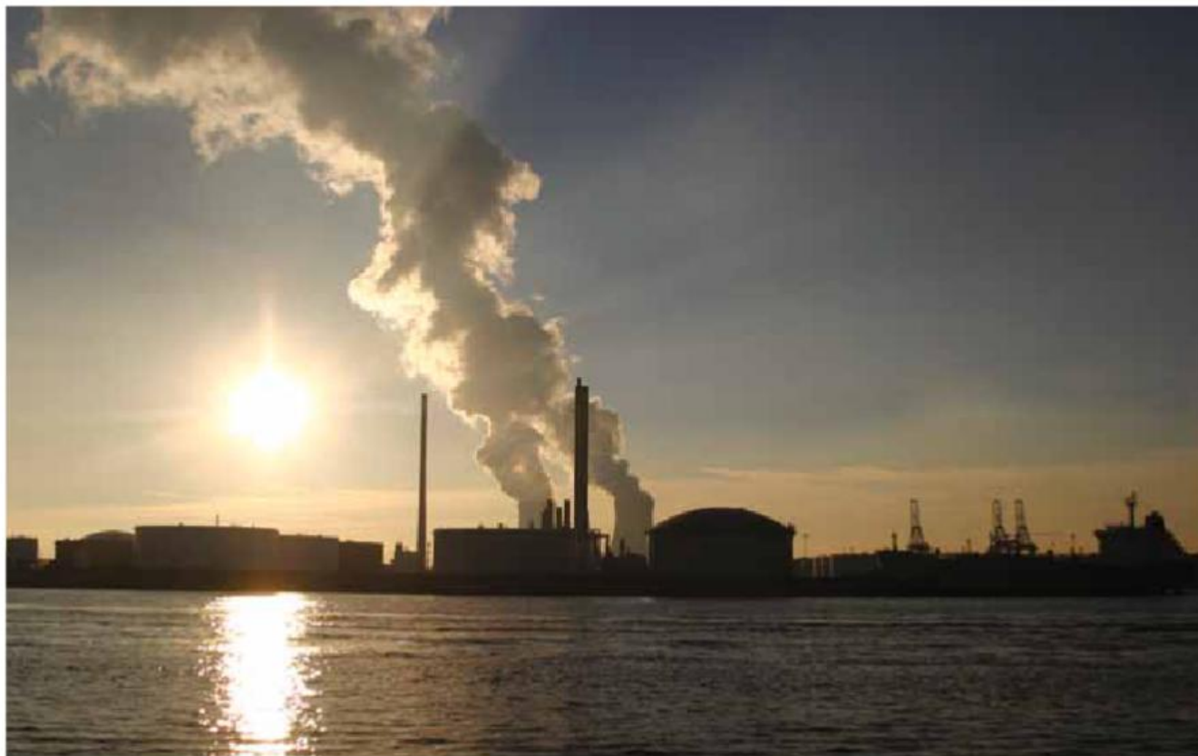
Energiecentrale © FARO. Foto: Bart Van der Moeren
